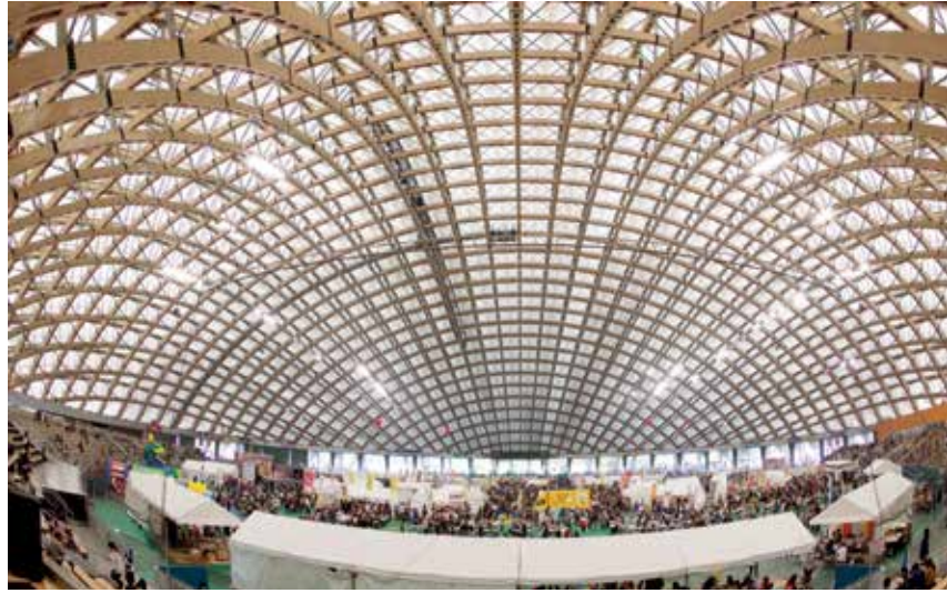
Odate Kubbesi, Akita, Japonya, 1997 (52 metre yüksekliğe 178 metre ve 157 metrelik akslar üzerinde uzanan devasa bir örtü. Çelik ve ahşabın birleşimiyle kurgulanan çatı sistemi, zemin kotunda açık bırakılmış.)
