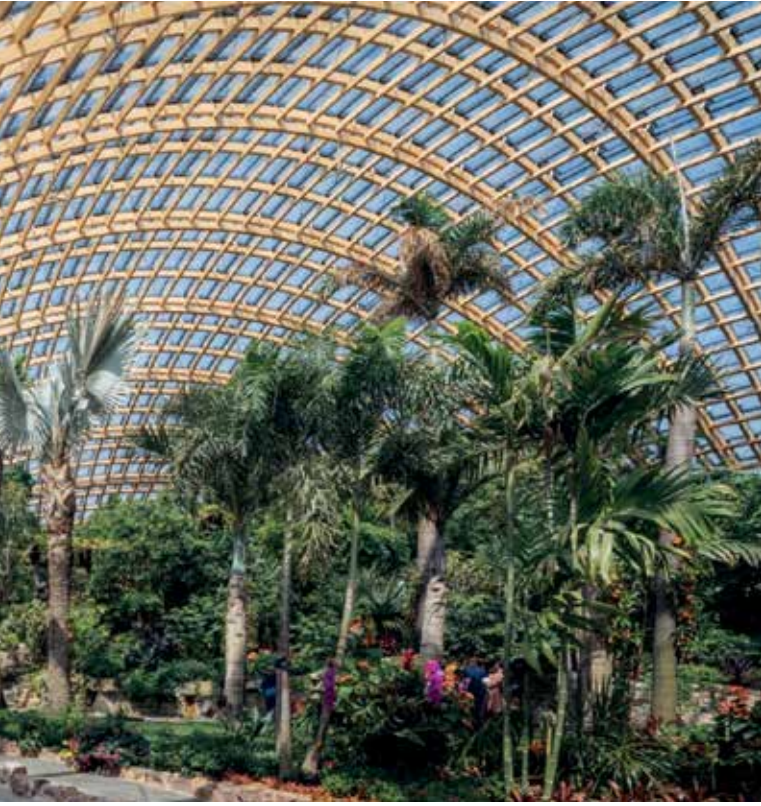
Odate Kubbesi, Akita, Japonya, 1997 (52 metre yüksekliğe 178 metre ve 157 metrelik akslar üzerinde uzanan devasa bir örtü. Çelik ve ahşabın birleşimiyle kurgulanan çatı sistemi, zemin kotunda açık bırakılmış.)
