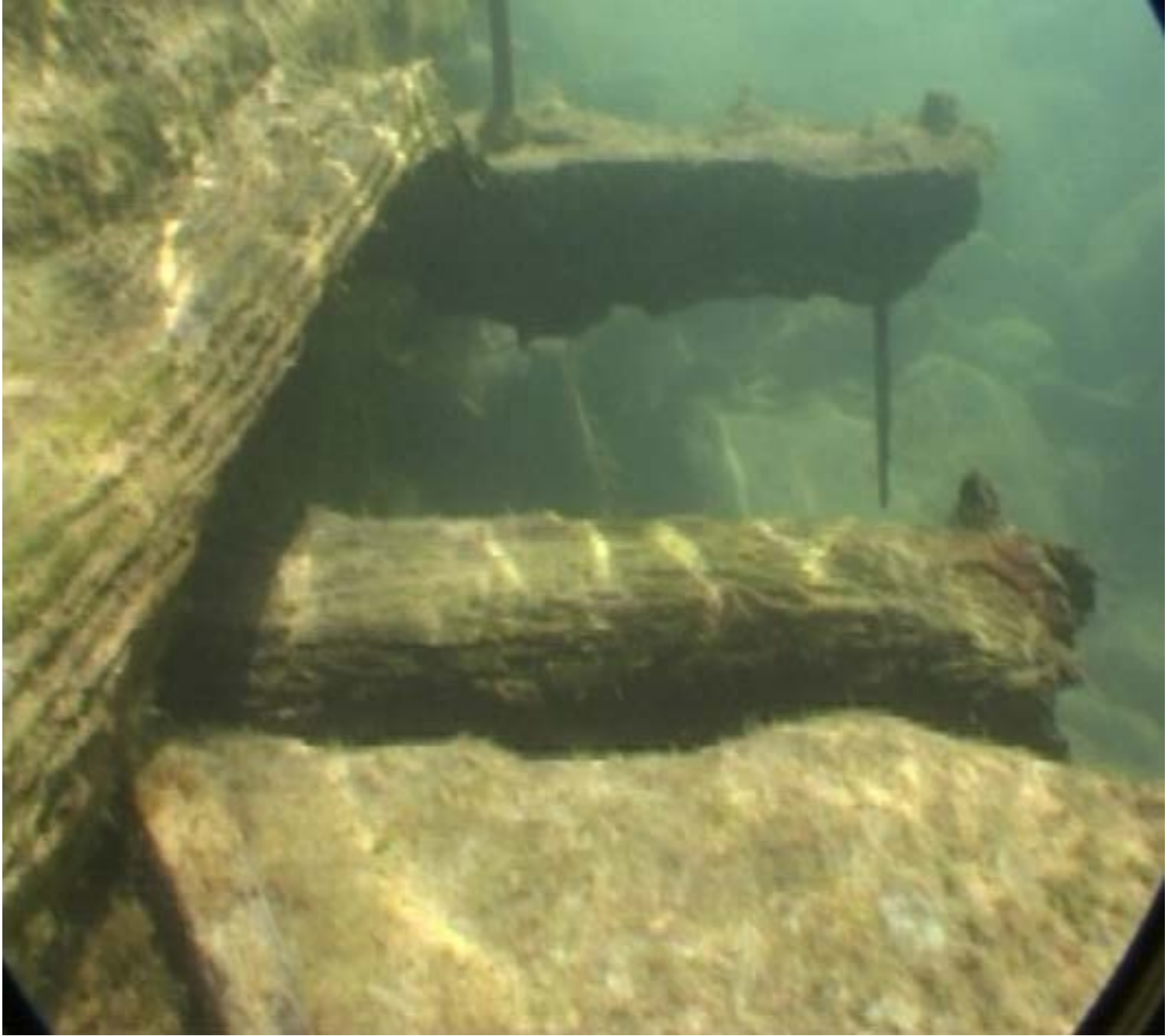
SU ALTINDA AHŞAP TEMELLER
